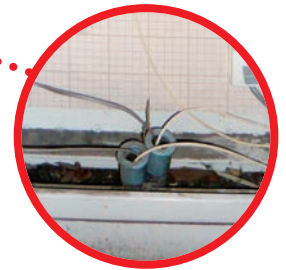
電話配管からの光ケーブル引き込み
